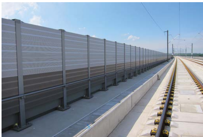
Bild 1 Lärmschutzwand an einer Bahnstrecke Noise barrier alongside a railway line
