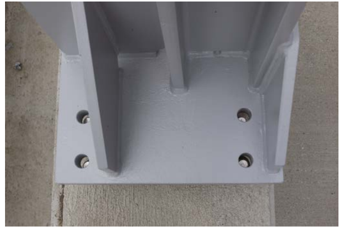
Bild 11 Ankerkorb 8M27 – ca. 4–5 cm Mörtelbett und 40 mm dicke Fußplatte, Durchgangsbohrungen mit 30 mm Durchmesser; auch bei Einhaltung der Toleranzen nach DIN EN 13670 bei Einbau des Ankerkorbes ist eine Montage des Pfostens so nicht möglich Anchor cradle 8M27 – approx. 4–5 cm grout bed, 40 mm thick base plate, 30 mm holes; even when adhering to the tolerances of DIN EN 13670 when installing the anchor cradle, it is not possible to set up the post in this way
