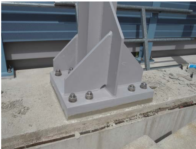
Bild 10 Nach Montageschritt 7 – Pfosten mit Unterermörtelung der Fußplatte After assembly step 7 – post with bed of grout under base plate
