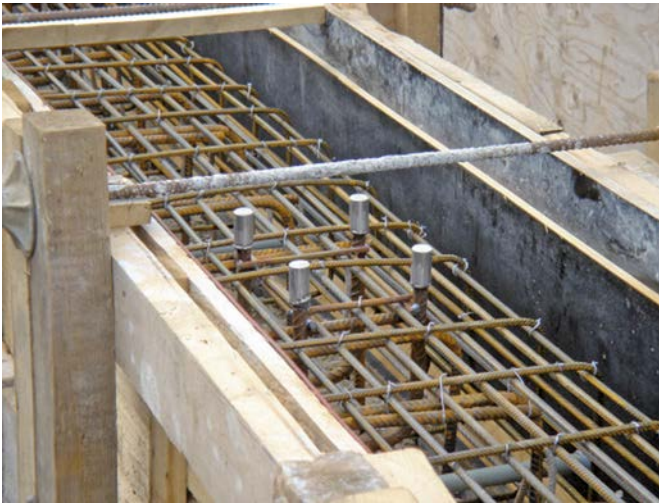
Bild 8 Ankerkorb in der Schalung – Ankerkorb nicht an den Ankerstäben mit der Bewehrung verschweißen Anchor cradle in formwork – do not weld anchor bars of anchor cradle to reinforcement
