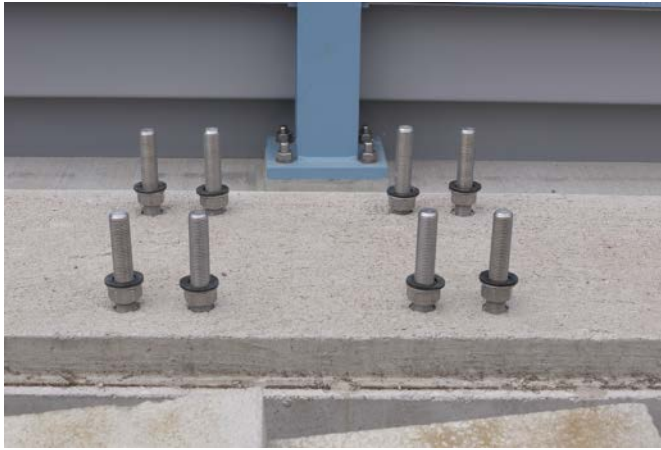
Bild 9 Montageschritte 1, 2 und 3: eingedrehte Gewindestangen mit Stellmutter und Elastomerscheiben Assembly steps 1, 2 and 3: threaded bars screwed in and fitted with adjusting nuts and elastomeric washers
